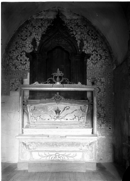
Fig.6 – Capela de São Torcato antes de 1924 Muralha - Associação de Guimarães para a Defesa do Património
