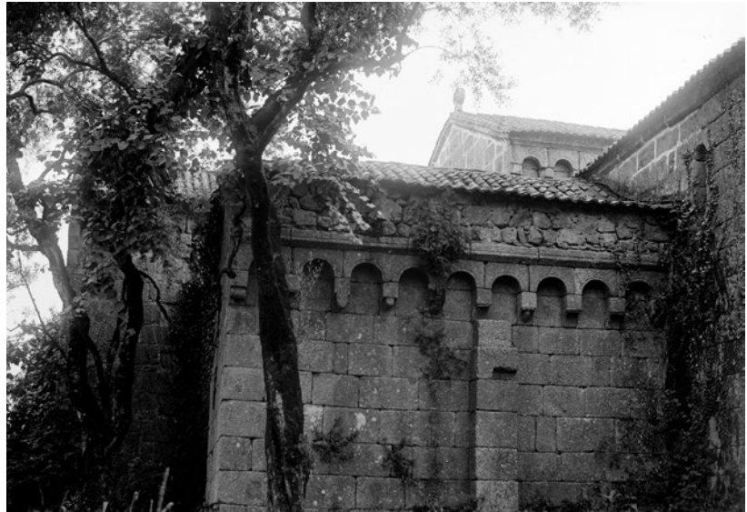
Fig.13 – Igreja de São Torcato: exterior da capela-mor, antes de 1924 Muralla-Associação de Guimarães para a Defesa do Património
